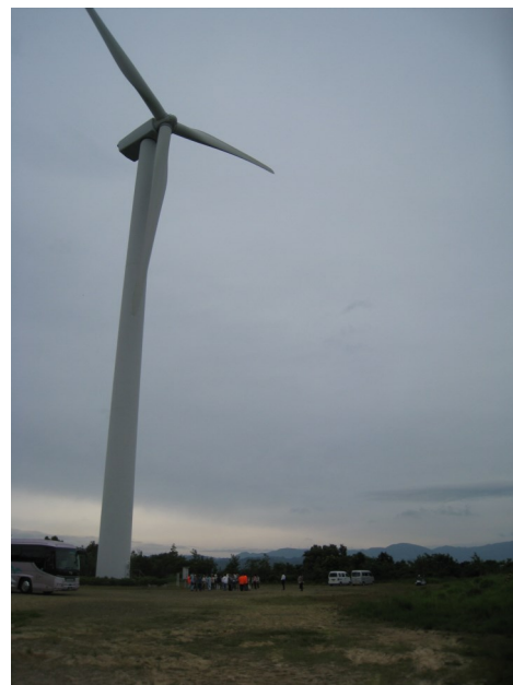
広川町大型風力発電所
