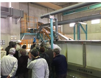
汚泥は脱水処理された後、脱水機に
